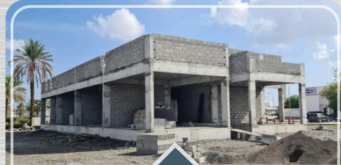
أنجز ما نسبته 45% من مشروع تشييد مبنى تدريب الانعاش القلبي الرئوي بمستشفى صحار The construction project of the CPR training building at Sohar Hospital has reached 45% completion
