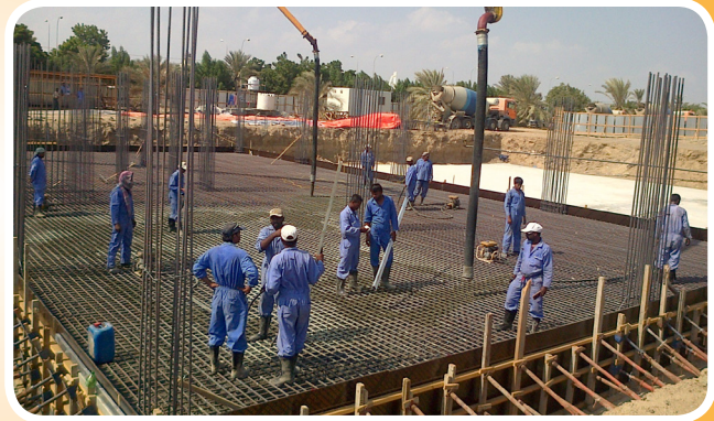
استمرار الأعمال الإنشائية في مبنى الوفاء المبنى الاستثماري لمركز لتأهيل الأطفال المعاقين (بصحار) Continuation of the Constructions Phase of Al Wafa Building (The Investment Building for Al Wafa Center – Sohar)
