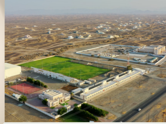
بناء المبنى الاستثماري لنادي الخابورة An Investment Building for Al Khaburah Club
