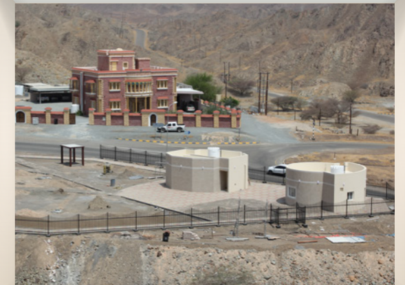
استمرار الأعمال في مشروع تطوير منتزه الحيلين بتمويل من صحار ألومنيوم Construction works continue at the Al Hailain Park
