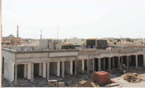
استمرار الأعمال الإنشائية في مشروع المباني الإستثمارية للأندية (صحار و السلام) Construction Works Progress at the Investment Buildings for Sport Clubs (Sohar, Al Salam)
