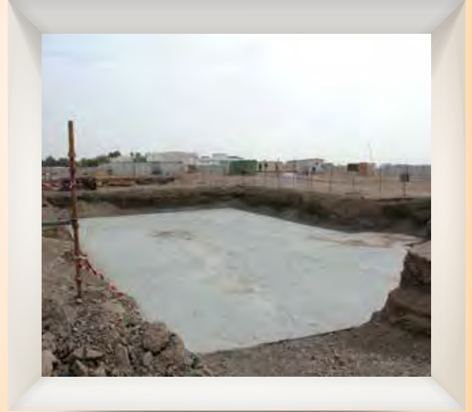
بء الأعمال الإنشائية في مركز الالهل من الإءمان Construction Works of the Drugs Rehabilitation Centre Begun
